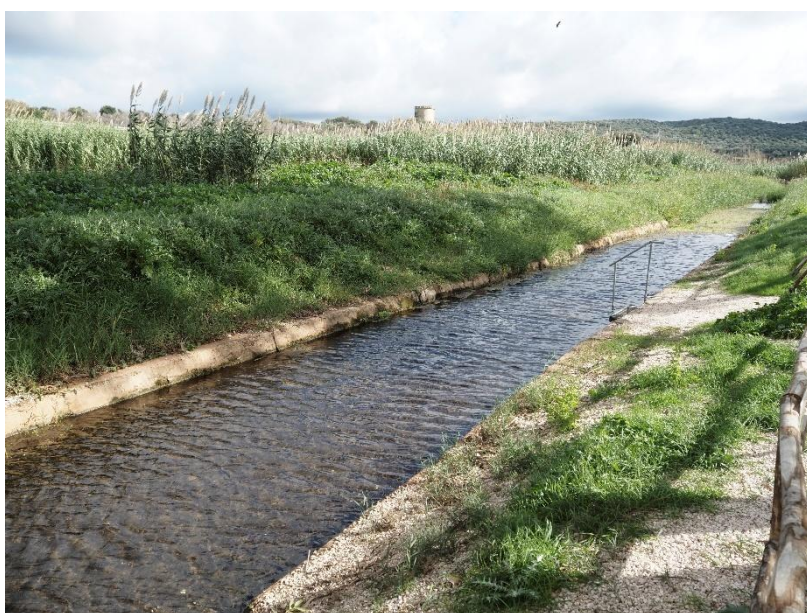
Scatto fotografico n. 1 dettaglio dell'alveo artificiale del T. Caldoli – Si evince la presenza di sponde realizzate in cemento armato
