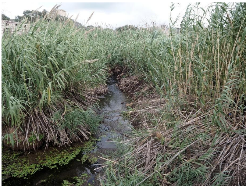
Scatto fotografico n. 2 dettaglio dell'alveo artificiale del T. Caldoli – Stato manutentivo
